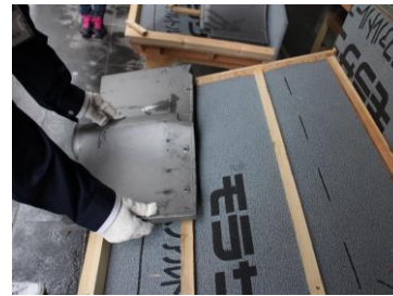
隙間がないよう、配置を整えながら瓦を置
