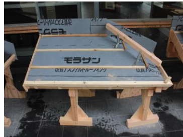
屋根模型を組立てる。
